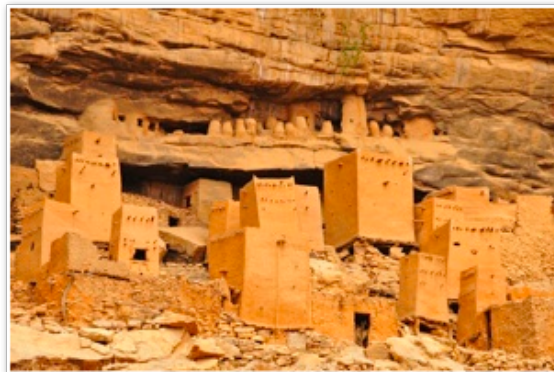
Die Dogon wohnen in der Falaise de Bandiagara am Abhang. Ihre Dörfer haben sie in teils schwindelerregender Höhe errichtet.
